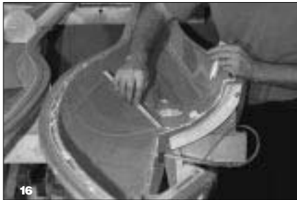
Auftragen von Harz und Einlegen der noch fehlenden Wabenstücke.
