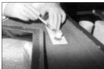
Aufbringen gefüllter Harze mit Pinsel/Spritztüte
