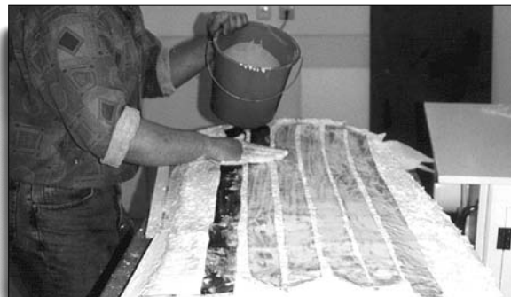
Das anschlussfertige Kohleband wird auf die erste Lage Laminierkeramik gelegt und getränkt.
